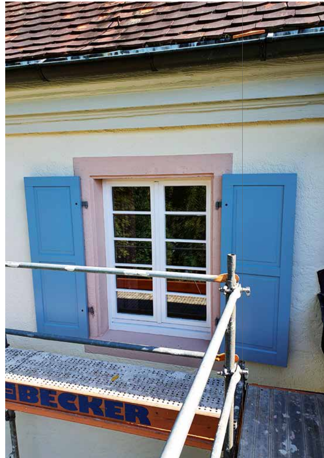
Fenster, Fensterläden und der Putz sind frisch gemacht
