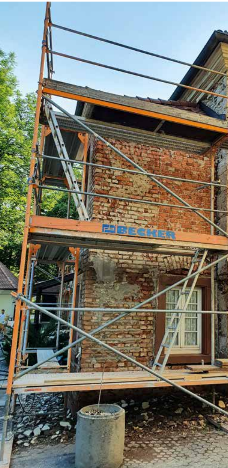
Der alte Putz musste bis auf die Mauern entfernt werden
