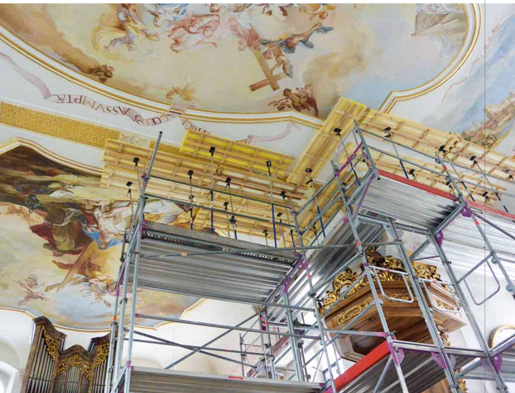
Gerüstbauten für die Innensanierung
