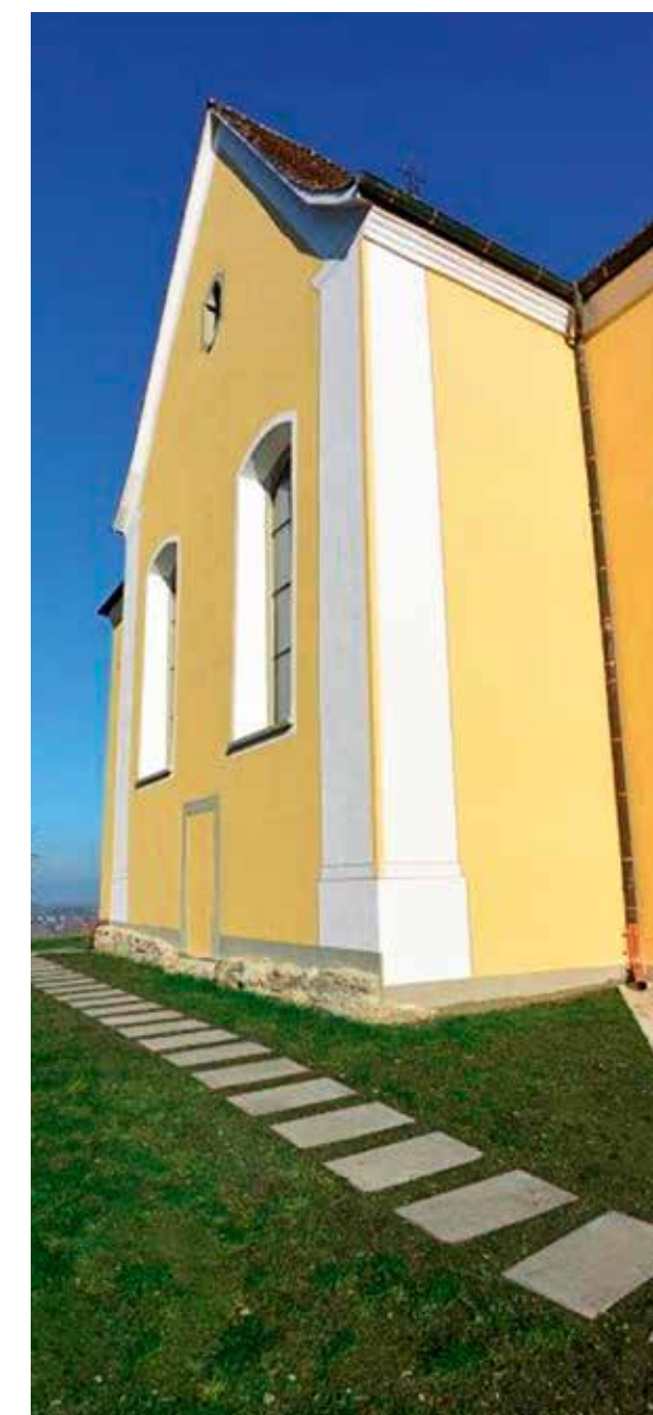
Das Gelb der sanierten Fassade leuchtet in die Landschaft
